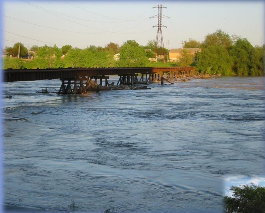
Старый мост через Терек
